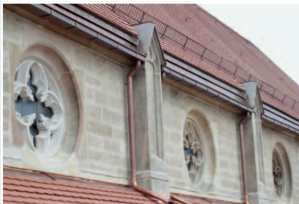
5 Obergaden vor der Restaurierung (o.) und restaurierter Obergaden (u.)
