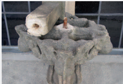
7 Bearbeitung des Verdachungssteins
