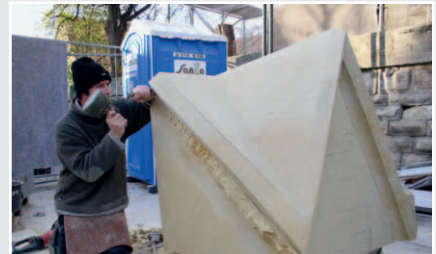
7 Bearbeitung des Verdachungssteins
