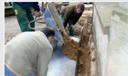
9 Abdichtung der Fundamente
