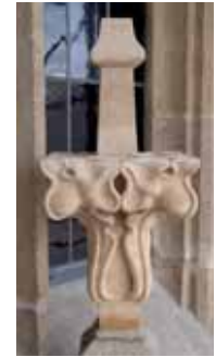
2, 3 Vollständig zermürbte Kreuzblume über dem nördlichen Eingang (links) und rekonstruierte Kreuzblume (rechts)
